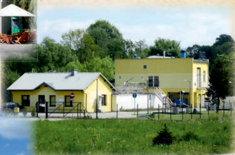
1995 - Oddanie do użytku oczyszczalni ścieków przy ul. Korczaka (widok po późniejszej modernizacji)
