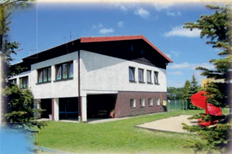
1994 - Zakończenie remontu przedszkola w Markłowicach Górnych
