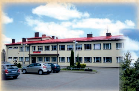
2012 - Termomodernizacja Domu Ludowego w Kaczycach
