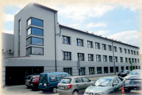
2014 - Zakończenie kolejnego etapu przebudowy budynku Urzędu Gminy w Zebrzydowicach
